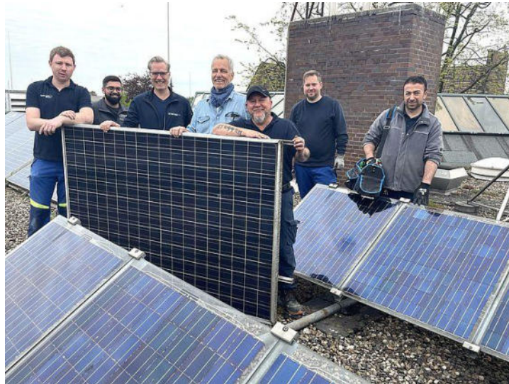
Runter vom Dach - ab in den Container: Die Crew aus Stadtwerken und Klimaschutzfonds bei der Demontage der Anlage.
